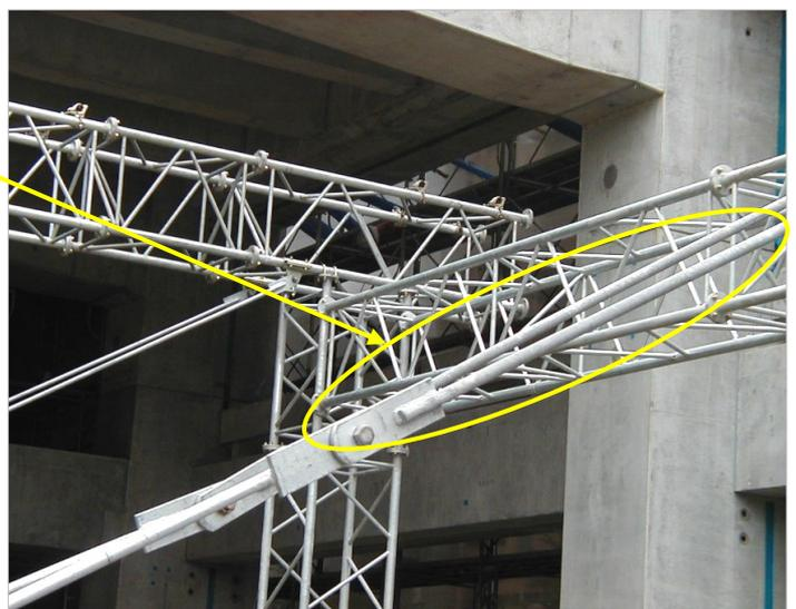
①調整ジャッキ ② ヒンジフランジ ③ブレース金物
