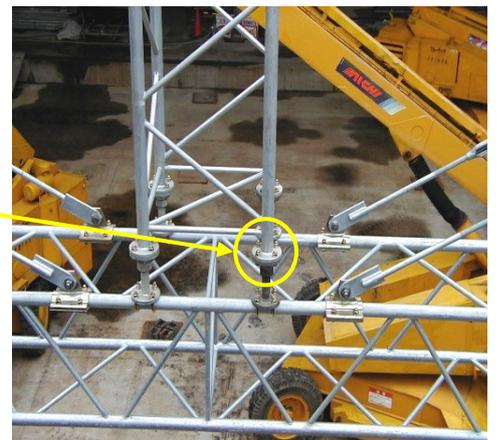
①ダブルクランプ ② 突っ張り補強材 ③ ブレース・ターンバックル
