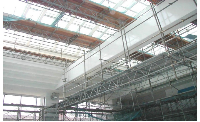
港区スポーツセンター改築
