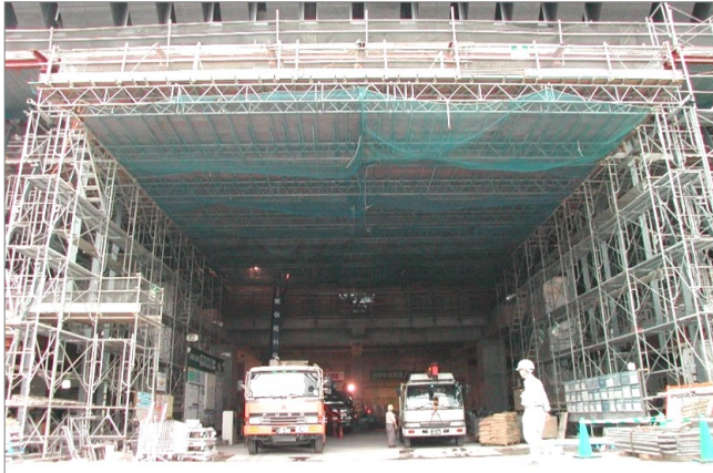
JR東海ビル(東京駅)
