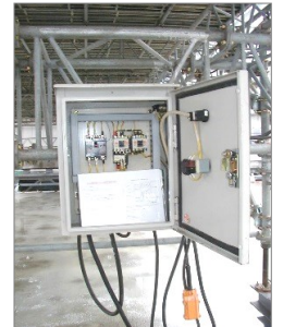
操作盤取付状況
