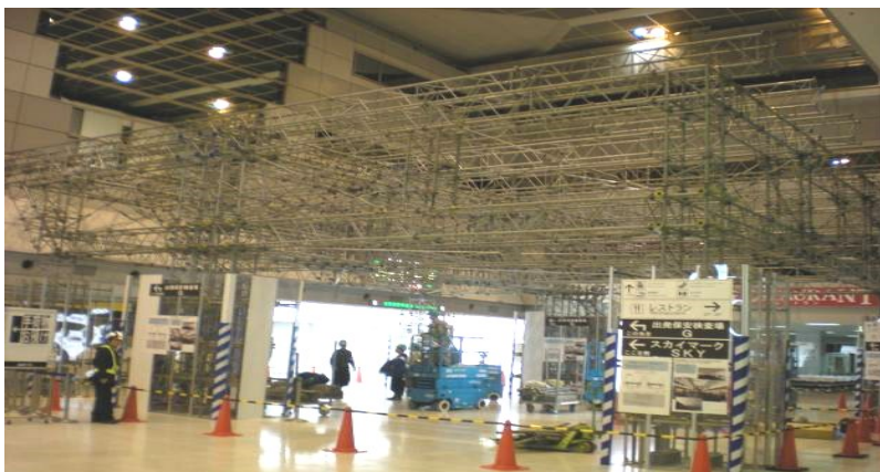
羽田日本空港ビル(JAL)チケットロビー改修
